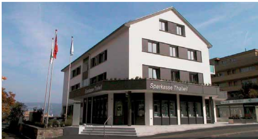
Der frisch renovierte Hauptsitz der Sparkasse Thalwil 2002
